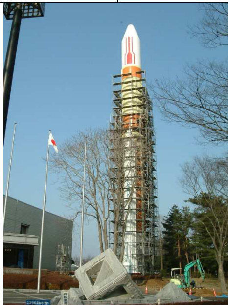
足場解体の様子
